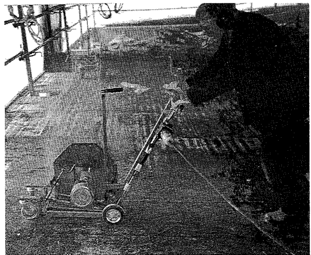
Sågvagnen i arbete på papptäckt råsponttak
